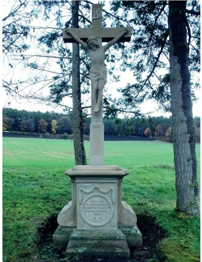
Die drei Nadelbäume stehen derzeit noch zu nah am Kreuz. Das Fundament wird dadurch leicht angehoben, daher werden diese demnächst noch entfernt.
