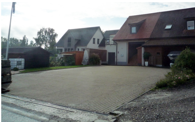
Negativbeispiel: vollständig versiegelter Hofbereich
