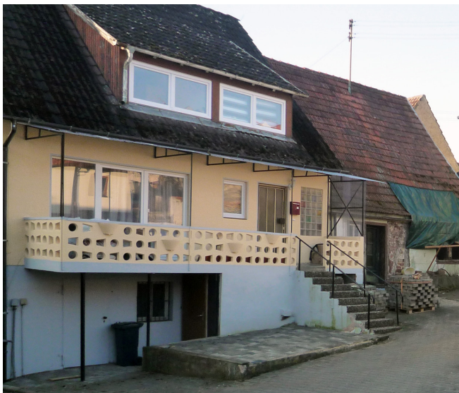
Negativbeispiel: unpassende Balkonbrüstung und Kunststoffüberdachung
