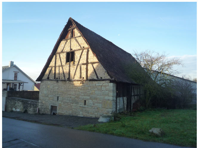
Scheune Naturstein / Fachwerk
