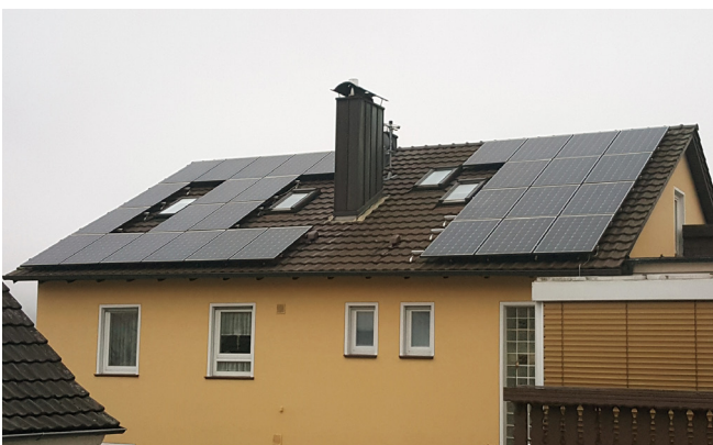
Negativbeispiel: unregelmäßig angeordnete Module
