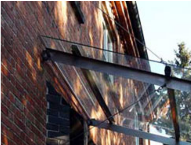
Beispiel für modernes Vordach in zurückhaltender Gestaltung
