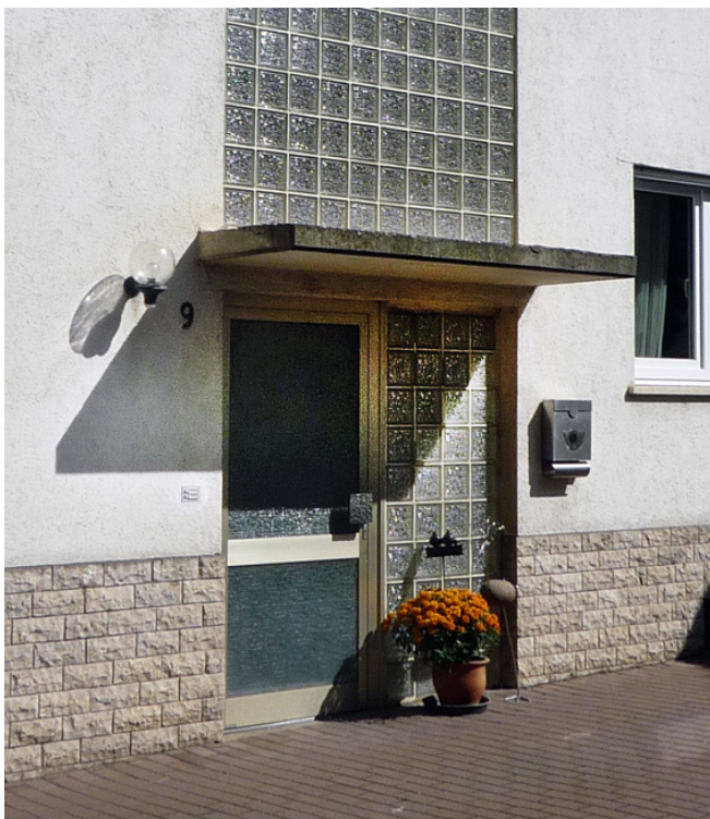
Negativbeispiel: Glasbausteine und strukturiertes Glas prägen den Eingangsbereich
