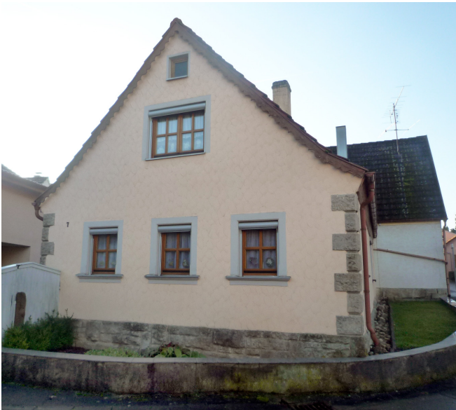
Traditionelle verputzte Fassade
