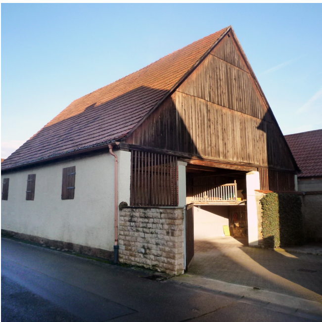
Scheune mit Holzverkleidung am Giebel
