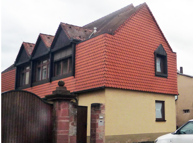
Negativbeispiel: Dach durch Gauben überformt, Deckung aus Kunststoff
