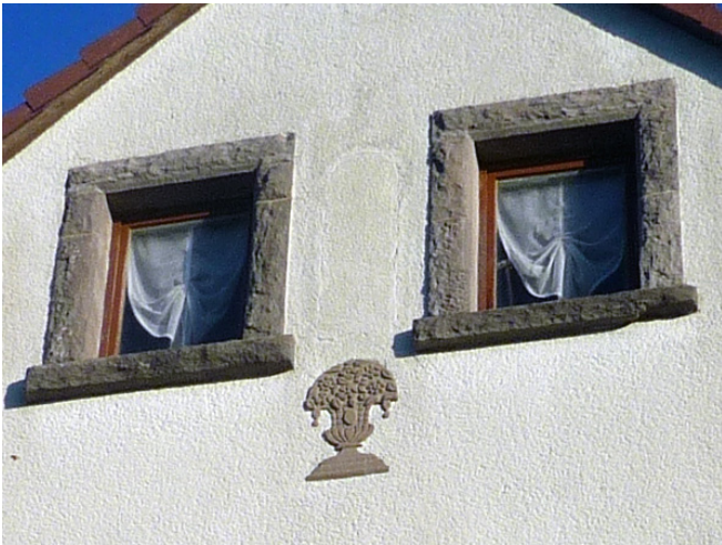
Fenster mit Steingewände
