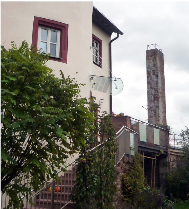
Beispiel für modernes Vordach und Treppengeländer am historischen Gebäude
