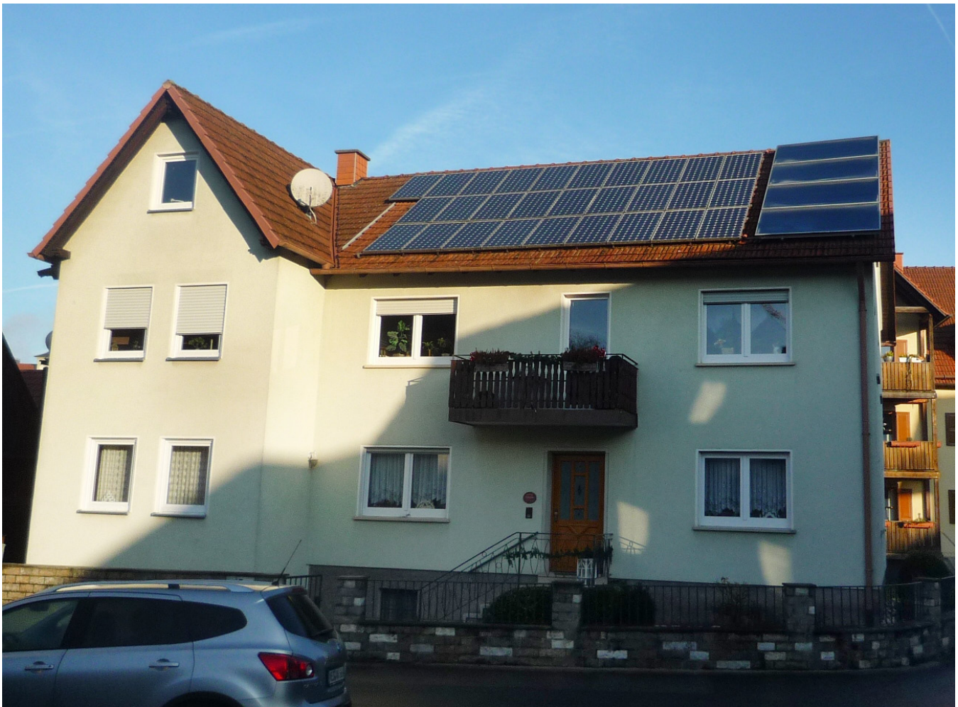
Anlagen zur Gewinnung von Sonnenenergie
