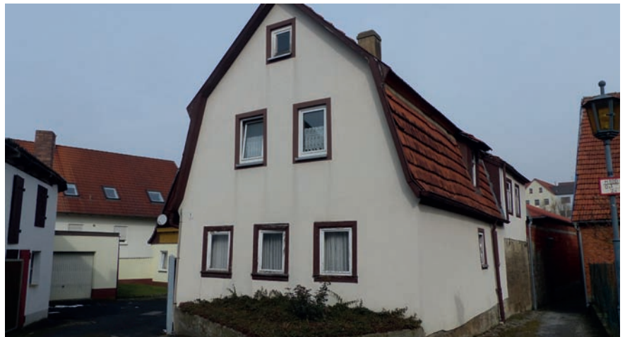
Leerstand Hofstelle P (Platzstraße 6)
