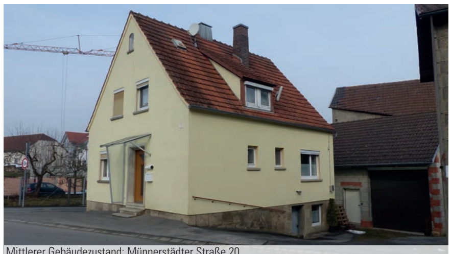
Mittlerer Gebäudezustand: Münnerstädter Straße 20
