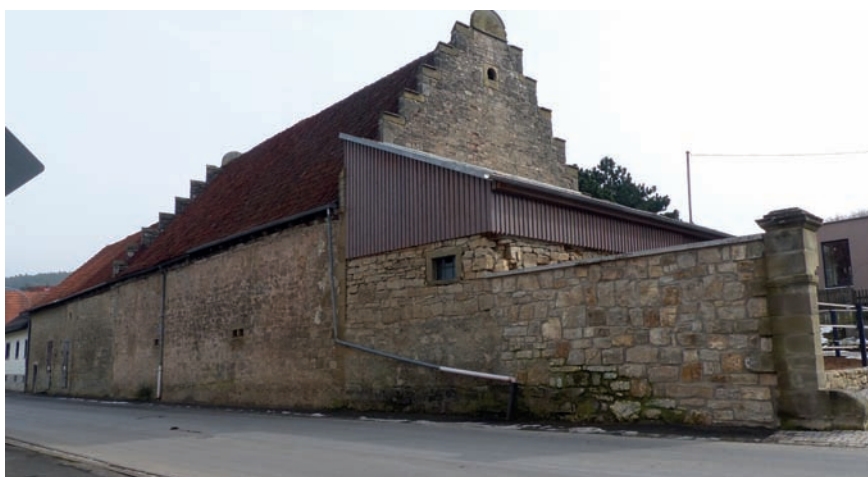
Baudenkmal: Ehem. Zehntscheune des Klosters Maria Bildhausen (Münnerstädter Straße)
