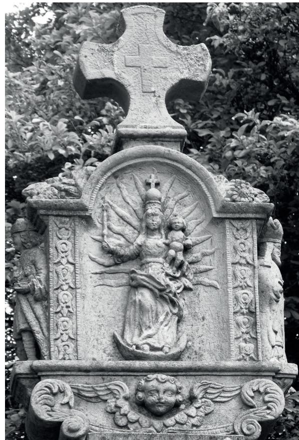
Im Jahr 2020 wurde an Ort und Stelle durch Michael Bauer, akademischer Bildhauer und Restaurator aus 97708 Aschach, eine Reinigung des Bildstockes mit kaltem Wasser bei geringem Druck (ohne chemische Zusätze) vorgenommen. Mit Epoxidharzmörtel, den er zuvor in Farbe und Körnung dem Original angeglichen hat, wurden schadhafte Stellen verklebt. Eine Inschrift ist nicht vorhanden.
